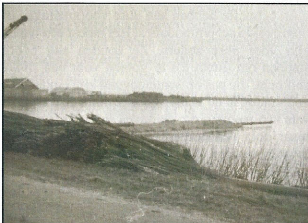
Jachthaven Ketelmeer in aanleg 1968.
